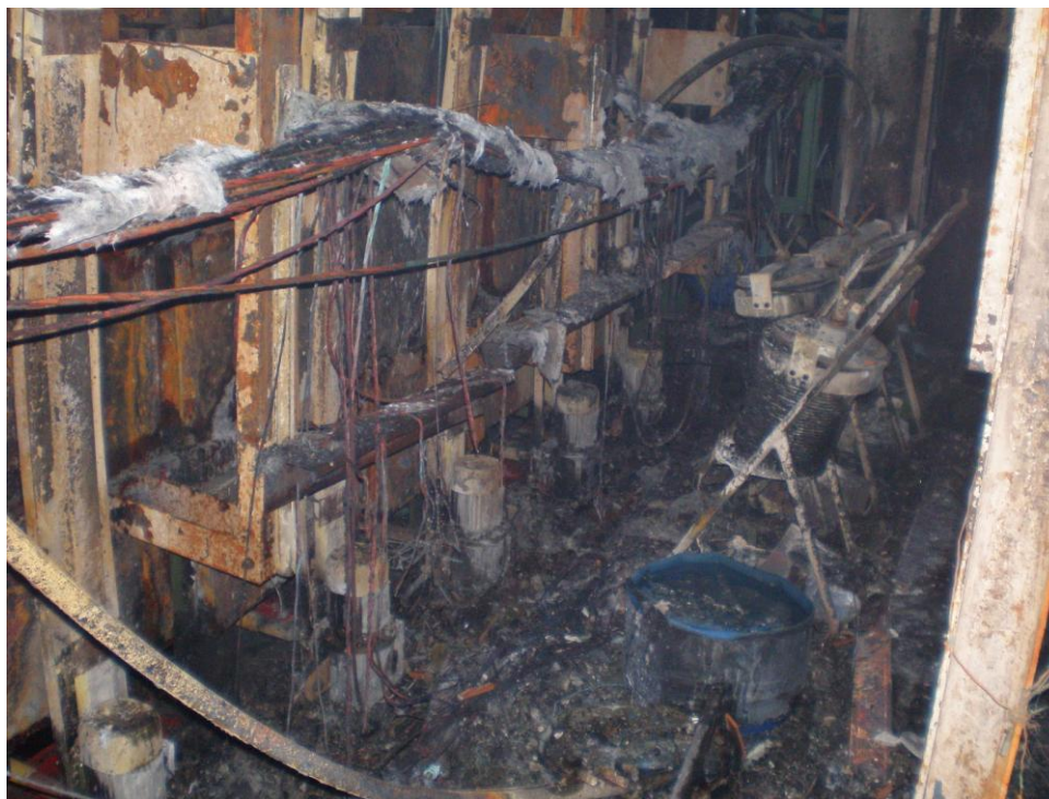
Figura 6: Incendio delle vasche della lavorazione nichel chimico
