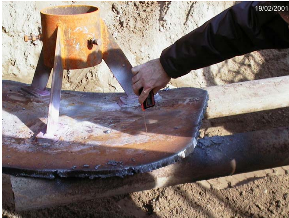
Fotografia n° 6 – Elemento inviato a laboratorio per prove
