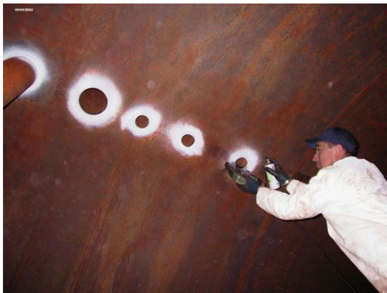
Fotografia n° 7 – Prove non distruttive su serbatoi D04 e D05
