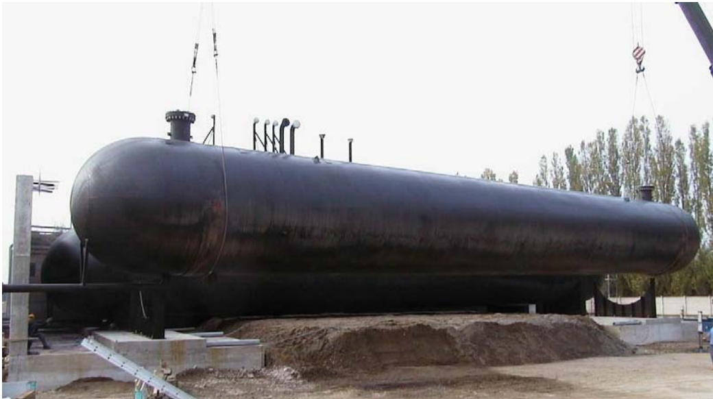
Fotografia n° 1 – Momento posa serbatoio D06
